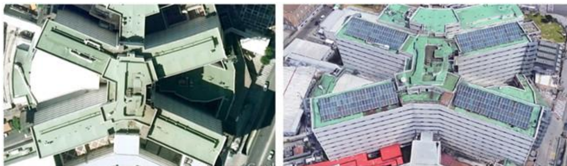
Figura 3: Cubiertas de un hospital antes y después de implantar la instalación solar térmica
