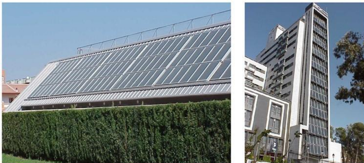
Figura 38: Ejemplos de integración arquitectónica de grandes instalaciones solares térmicas
