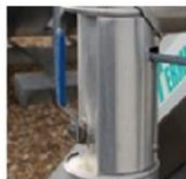
Figura 75: Ejemplo de válvula de corte, instalada con mando accesible y símbolo habitualmente utilizado
