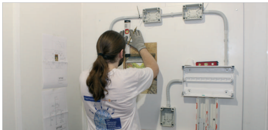
Los concursantes desarrollaron en su cubículo una completa instalación.
