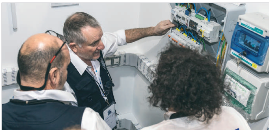
Comprobaciones del jurado en el Concurso de Jóvenes Instaladores
