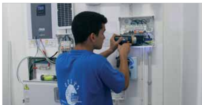
Concursante realizando la instalación
