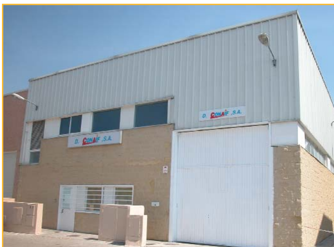
Con la apertura de esta nave se consolida Distribuciones Conaif
