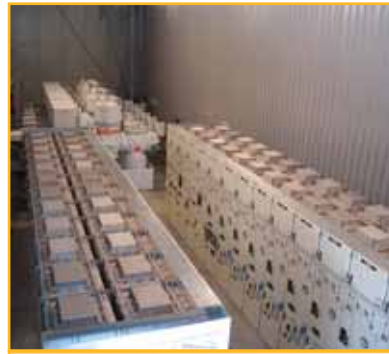
La subestación Rastro
